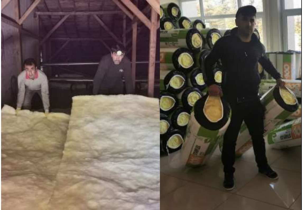
Fotoğraf.8: atı İzolasyonunun Tamamlanması
