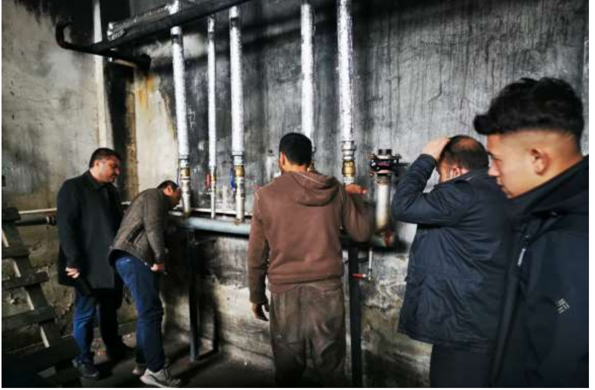
Fotoğraf.7: Bina Sihhi Tesisat ve Kaldorifer Borularının Deęiřimi
