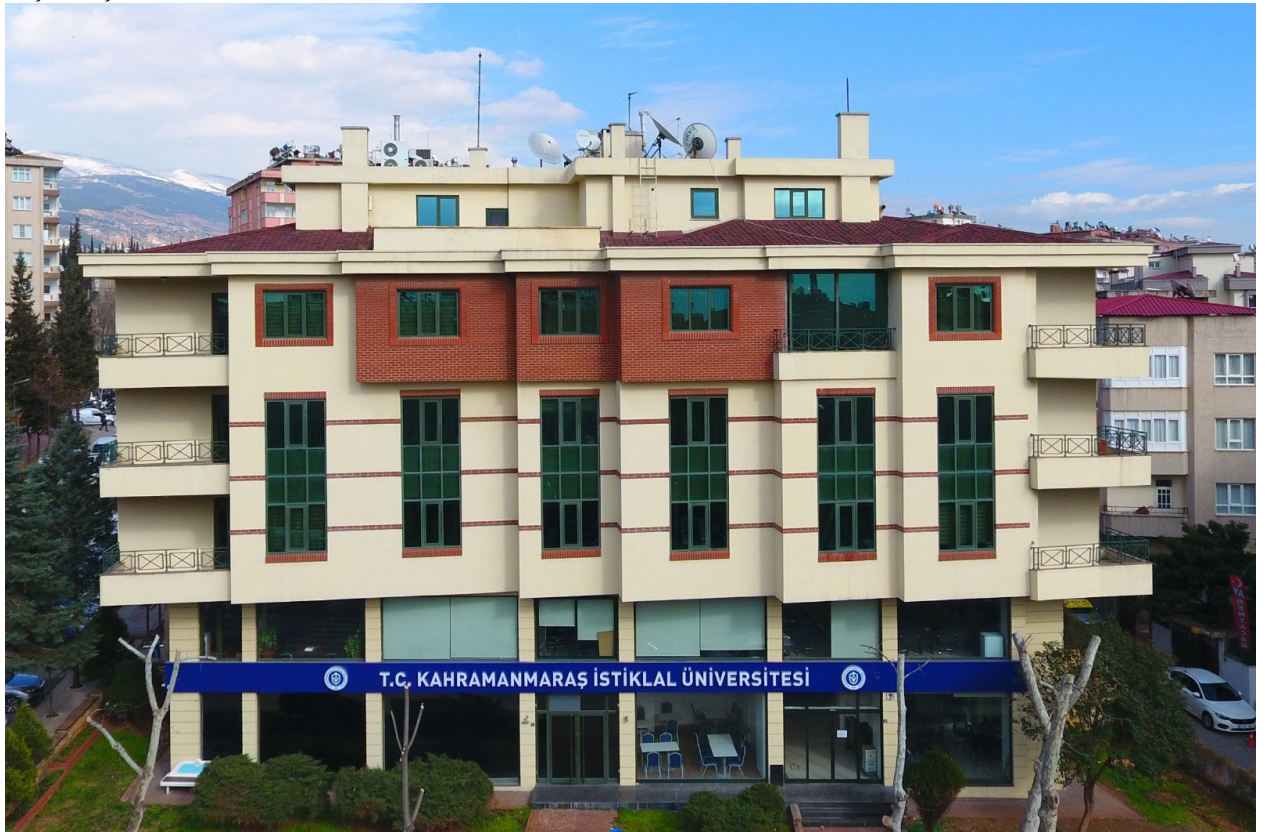
Kahramanmaraş İstiklal Üniversitesinin Rektörlük ve Bağlı Birimler Yeni Hizmet Binası
